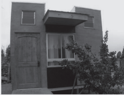
Fig. 16: Caso 8. Vivienda Autónoma. Comuna La Unión, XVI Región de los Ríos. Caso 19. Módulo Habitable. Comuna Vicuña, IV Región Coquimbo.
