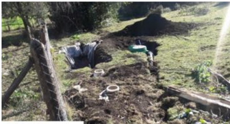
Instalación Fosa Séptica
