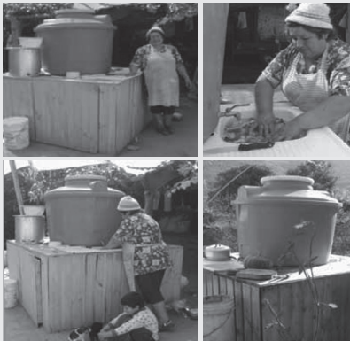
Fig. 11 Caso 63. Estanque Acumulador con lavadero incorporado. Comuna San Javier.
